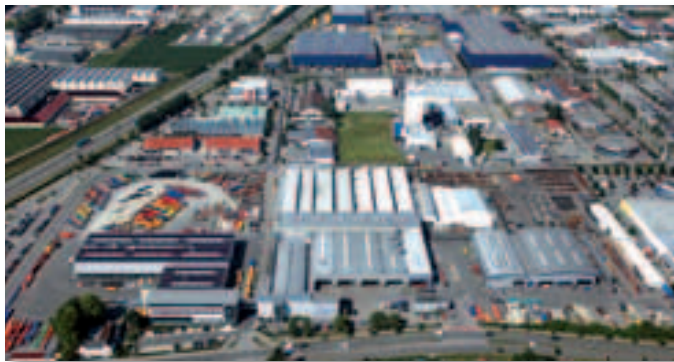
Nahwärmenetz Industriegebiet, Memmingen Nord
