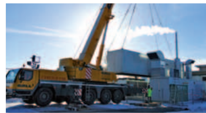
Auf dem Weg zum Einsatzort – VE-Wasser, Arbeitsbühne oder mobile Anlage
