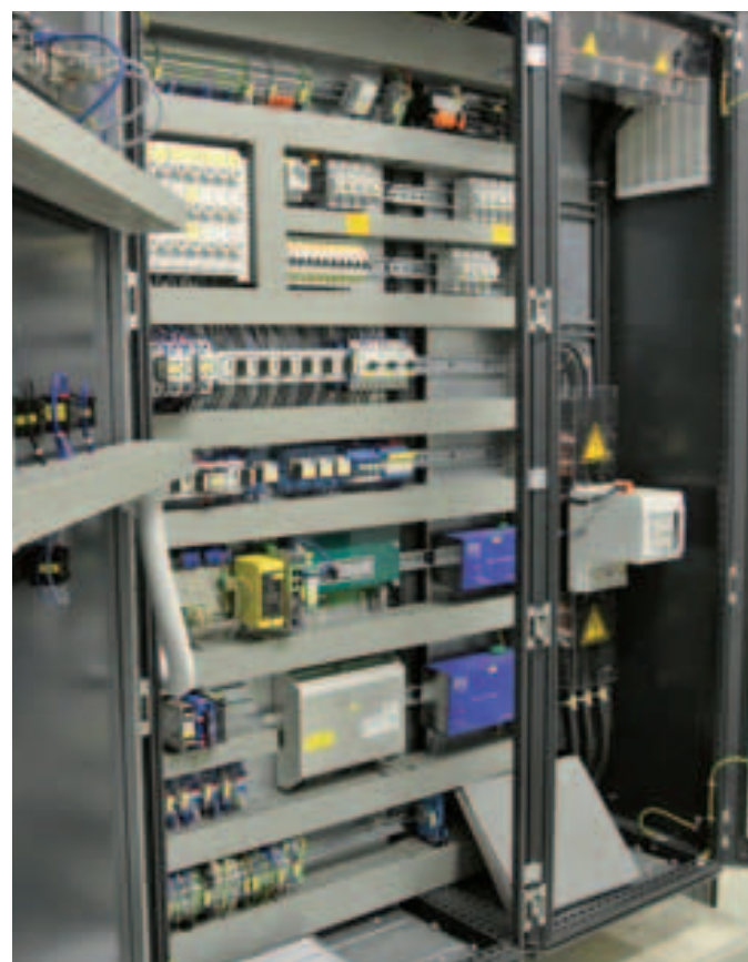
Dänisches Bettenlager GmbH & Co. KG, Kammlach
