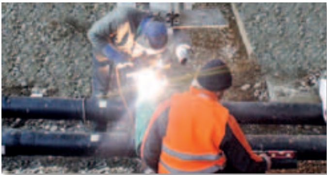
Rohrleitungsbau mit AGFW-Zetifikat
