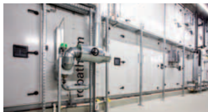
Klinikverbund Kempten-Oberallgäu gGmbH, Klinikum Kempten
