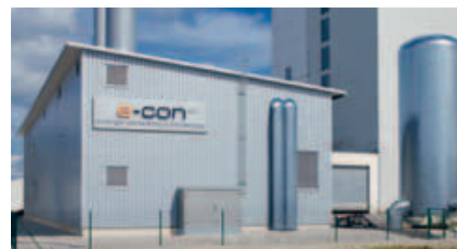
e-con AG, Memmingen – Heizwerk Industriegebiet Memmingen Nord
