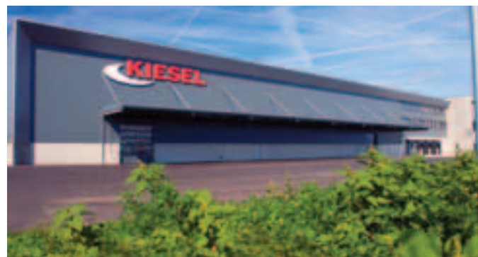
Kiesel Mitte GmbH, Stockstadt/Rh. (Bildquelle Viessmann)
