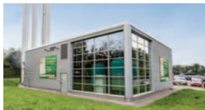
ZAK Energie GmbH, Kempten
