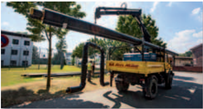
Rohrleitungsbau mit AGFW Zertifikat
