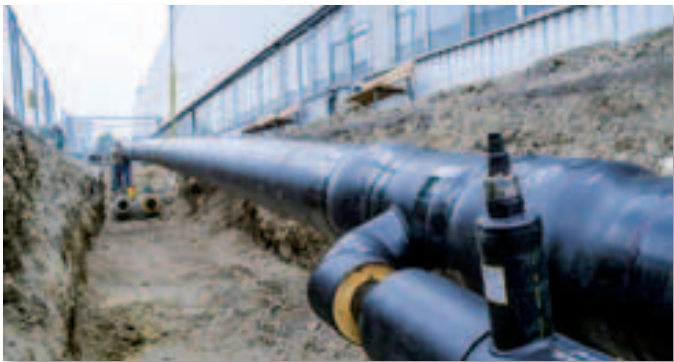
Fernwärme Mindelheim der Erdgas Schwaben GmbH
